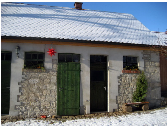
Förster- und Heimatmuseum Münchengosserstedt: sanierte Fassade des Nebengebäudes (Quelle: Büro für Architektur und Städtebau Schudrowitz, Apolda)
